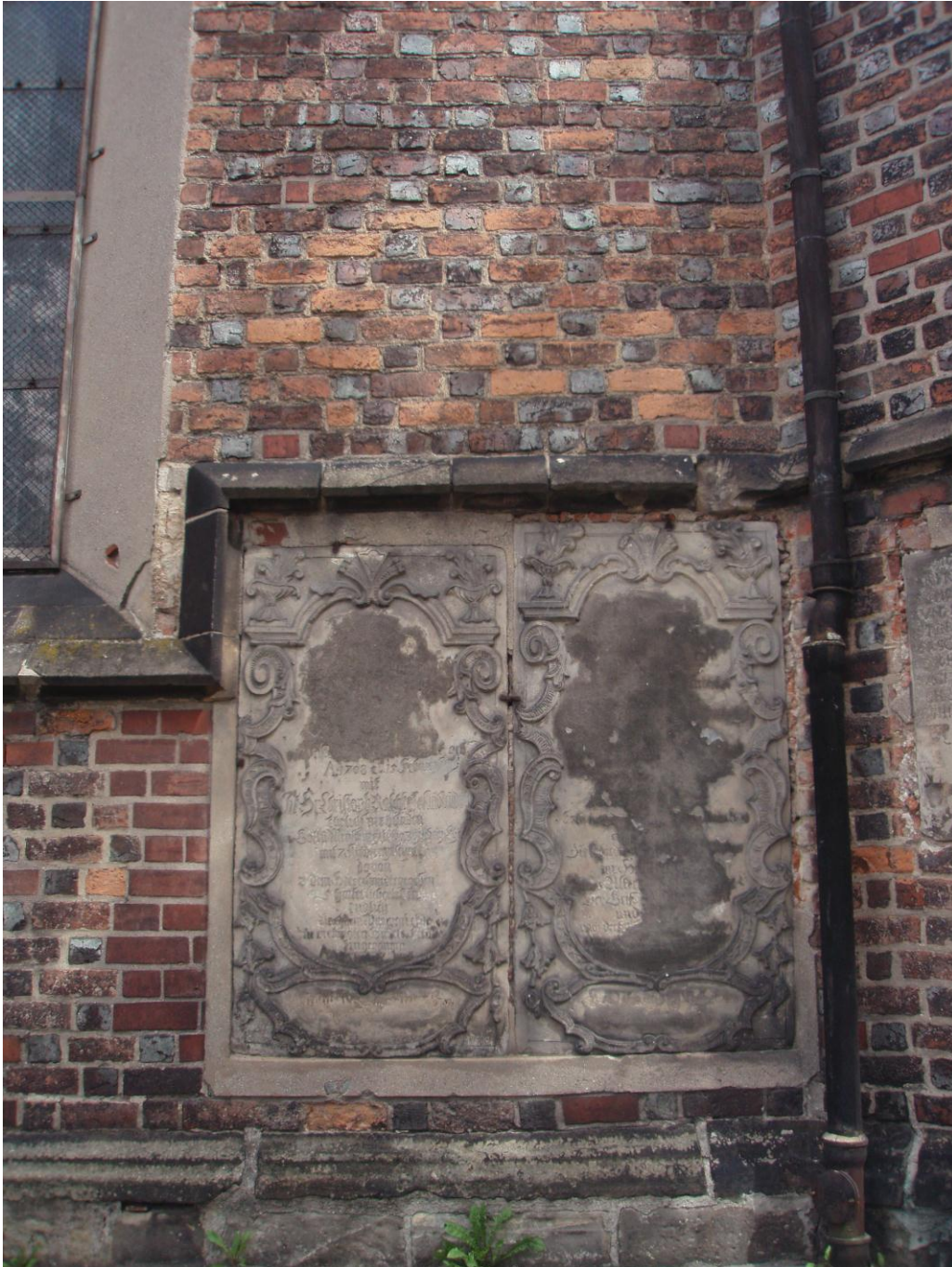
Die barocken Epitaphien außen an der Kirche sind mit Mörtel überzogen worden, um die deutsche Schrift auszulöschen, der zum Teil abgeplatzt ist (Juli 2012)
